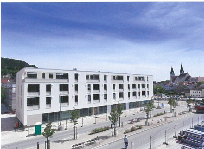
Bild 2. Eines der Gebäude in der Wohnbebauung „Herzog-Anger“: Neben den Fenstern sind die Außenlufthauben der Thermo-Lüfter zu erkennen
